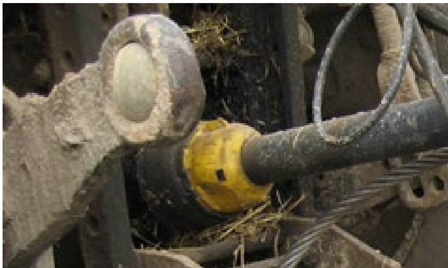
Рисунок 9 – Установка карданного вала привода насоса гидросистемы полуприцепа.
